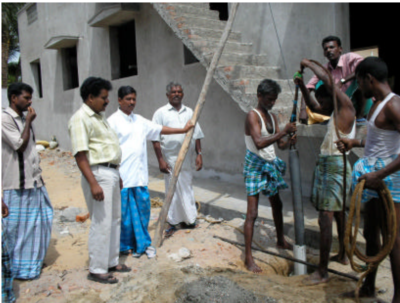
Digging the borewell Erdarbeiten für den Bohrbrunnen
